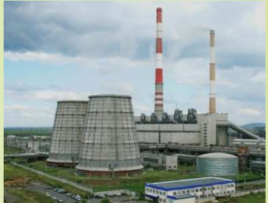
Усть-Илимская ТЭЦ - расположена на промышленной площадке Усть- Илимского лесопромышленного комплекса.
